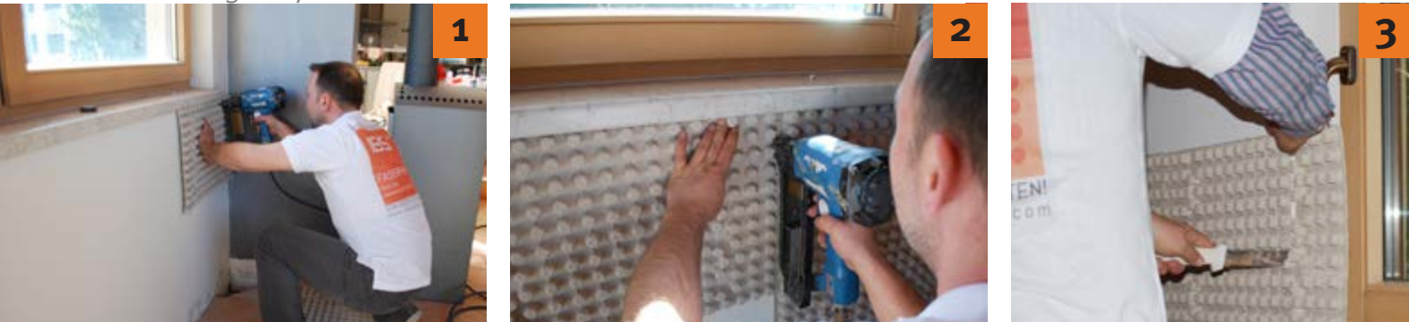
Montage auf Ziegel oder Beton
