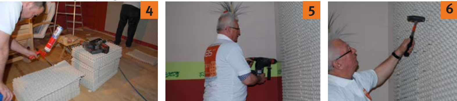
Verlegen von Heizleitungen
